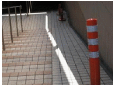
写真③ 地下道の階段
