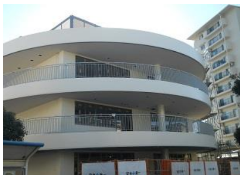
北側から見た新校舎
