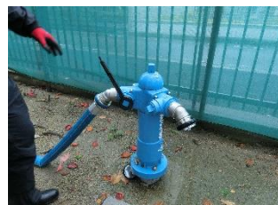
応急給水栓にホースをつなぐ
