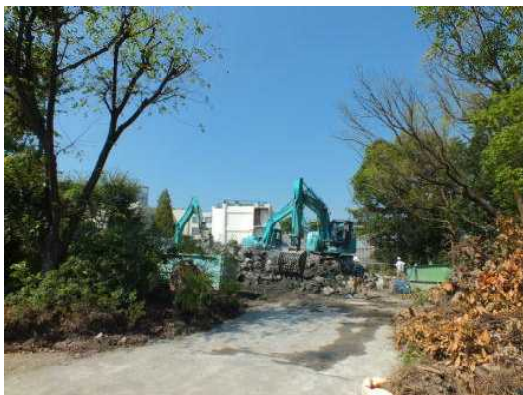
北門から見た風景です。東校舎の土台が残っています。
