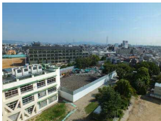
南校舎の屋上から見た風景です。東校舎がすっかり取り壊され、尼崎西高がよく見えます。
