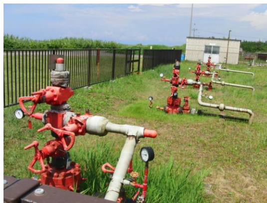
地下につながっている井戸
