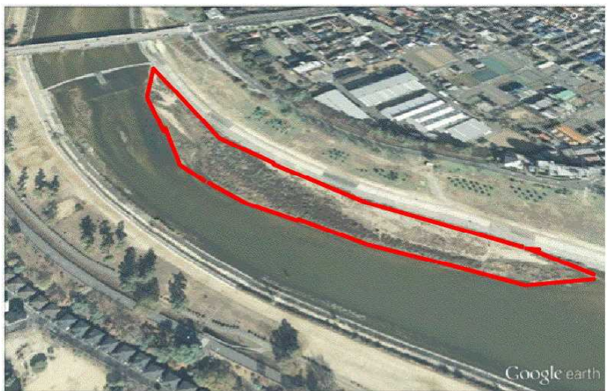
武庫川大橋付近に見られる堆積
