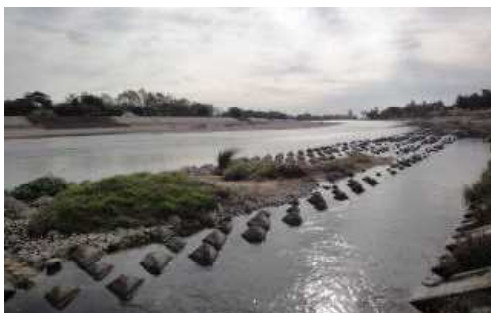
カーブの外側の護岸ブロック
