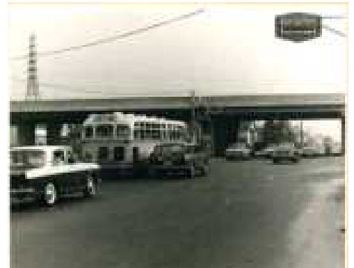
立体交差 上は高速 下は産業道路
