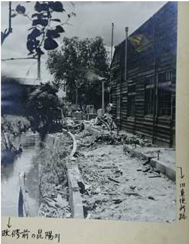
学校東端 昆陽川改修に伴い便所を取り壊す
