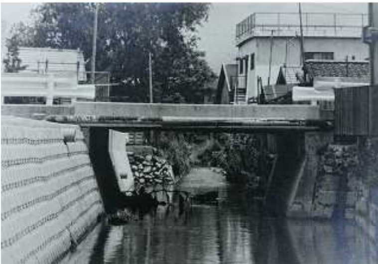
改修の終わった右岸(左手川岸) 学校南門前の道路に架かる橋
