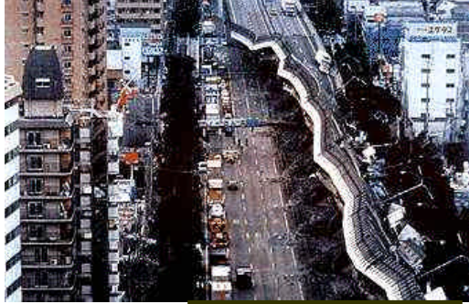
倒壊した阪神高速道路
