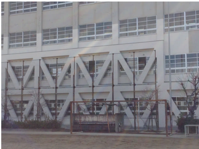
運動場から見た北校舎：工事したところだけペンキが…
