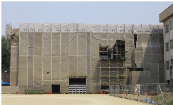
<内部は完成が近い体育館>
