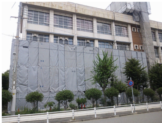
<南校舎も工事が始まりました>
