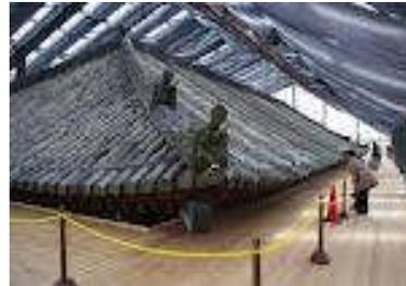
右の写真は皆さんがよく見る『正倉院』の姿です、左が改修工事の様子です。現在は左の状態から全ての瓦が取り除かれて漆喰の土も落として下地の状態になっています。漆喰の土と約3万枚の瓦全てを乗せるとその重量は約200トンになるそうです。そんな重量も計算され梁や柱が作られているなんて約1300年ほど前の技術のすばらしさに感心します。
