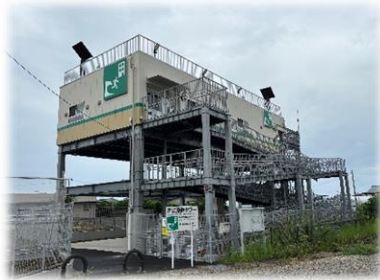
津波避難タワー
